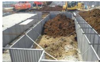
次工区の掘削に移ります。そこで出た掘削残土を埋め戻しに使用します。
