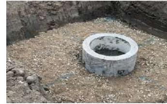
レベルコンを打たずに型枠をセットするので念入りに転圧します。
