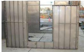
型枠地組みヤードにて掘削と並行して型枠を地組みします。
