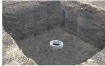
床付け天端も図面を元に管理します。
