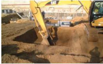
フーチング、梁に合わせて最小限の余掘り掘削します。
