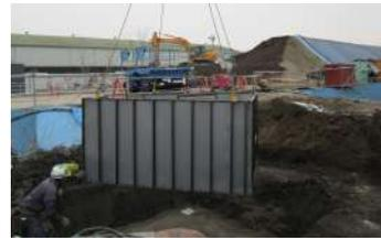
地組みしたフーチングをセットし、トランシットで位置を確認してから梁を取付けます。
