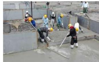
基礎鉄筋組立てを考慮し、レベルコンを打設していきます。
