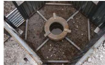
先行埋め戻しに備え、型枠が下端からすくわれないように打ち込みや控え止めなどで補強します。
