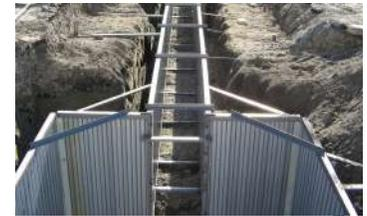
火打ちや巾止めなどで型枠のたおれや通りを見ながら補強します。
