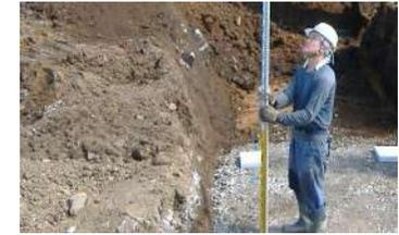
レベルコン後打ちなので型枠下端のレベルを出すためにセットします。
