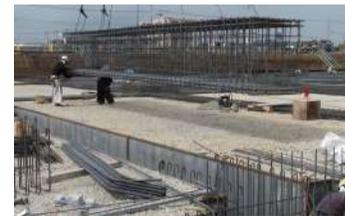
鉄筋は地組みして落とし込みします。ここからの作業は鉄筋施工業者になります。
