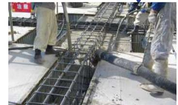
鉄筋配筋と継ぎ手作業が終了したら基礎コンクリートを打設します。
